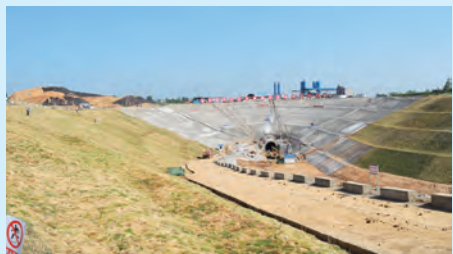
袁冲暗涵边坡绿化
