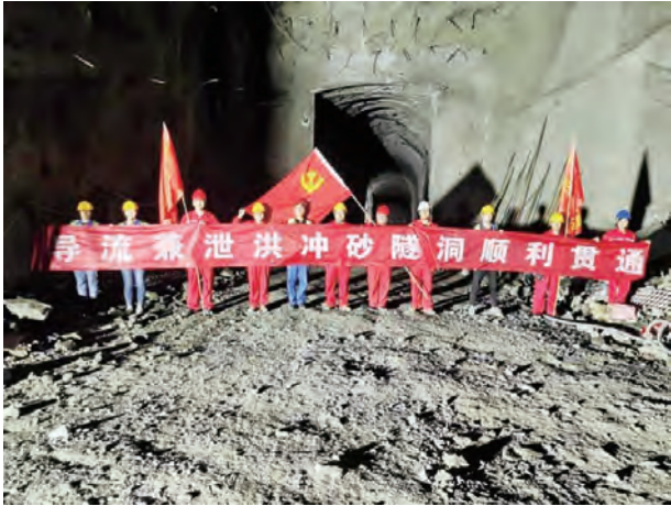
2022年8月26日，库尔楚水库工程导流兼泄洪冲砂隧洞顺利贯通
