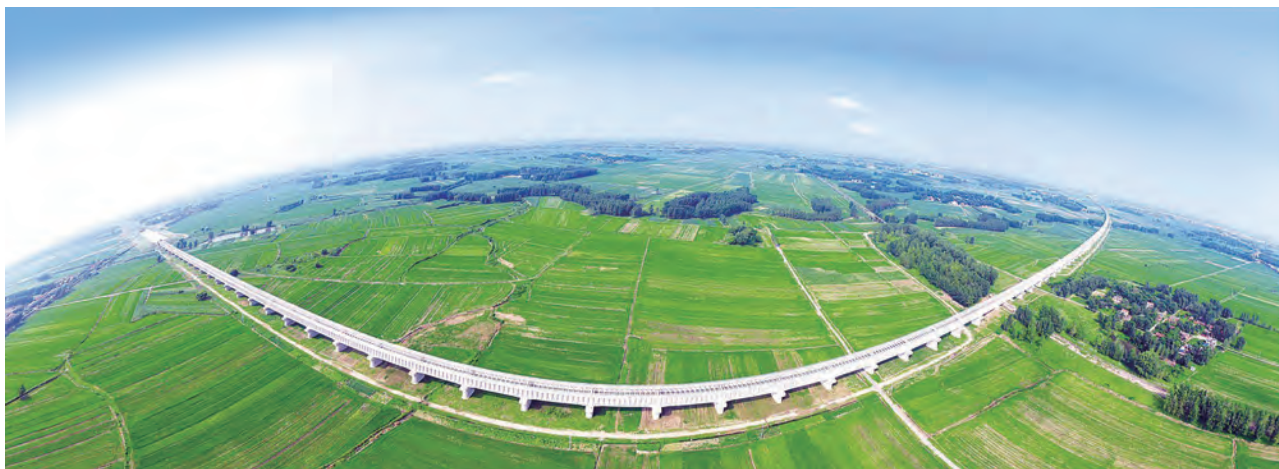
鄂北水资源配置工程
