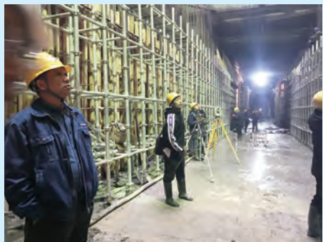
取水竖井第一模模板验收
