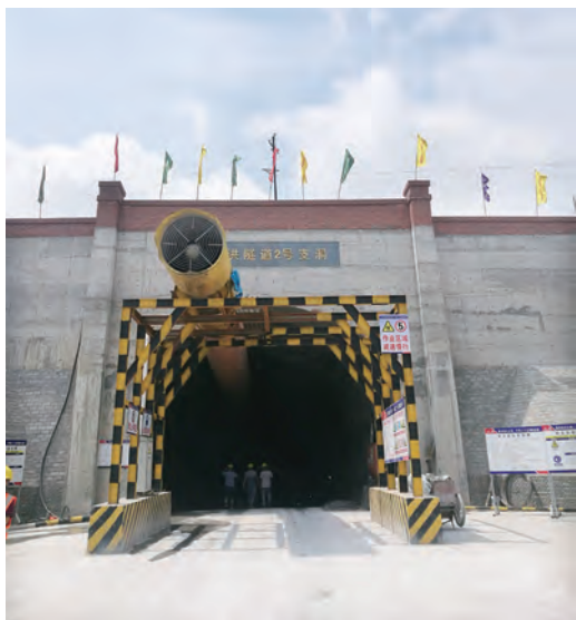
纪洪隧洞2号施工支洞进口
