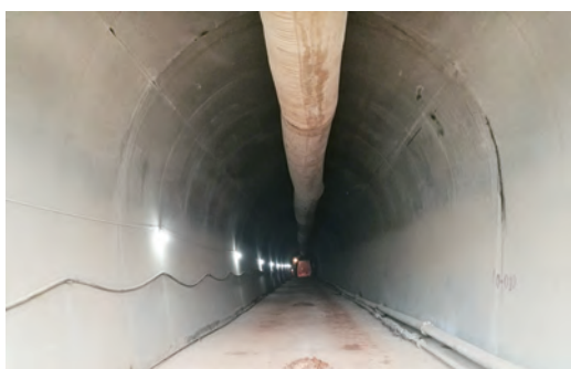
纪洪隧洞2号施工斜井现场干净整洁
