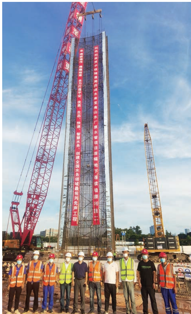
2号竖井地连墙钢筋笼（超危大工程）全部顺利吊装完成
