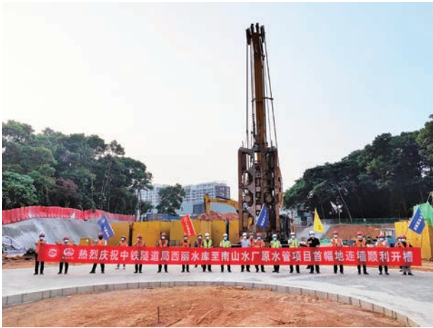
2号竖井地连墙钢筋笼（超危大工程）首幅顺利吊装完成
