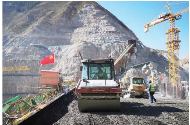
混凝土碾压施工中
