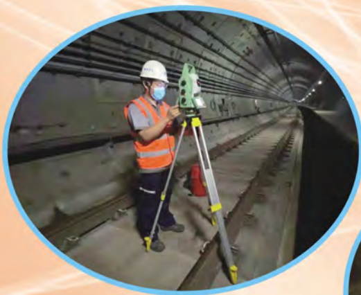
2号线区间水平位移观测
