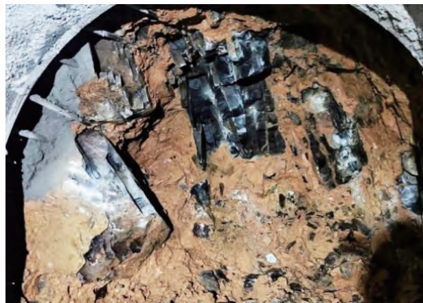
3#隧洞进口工作面岩性变化
