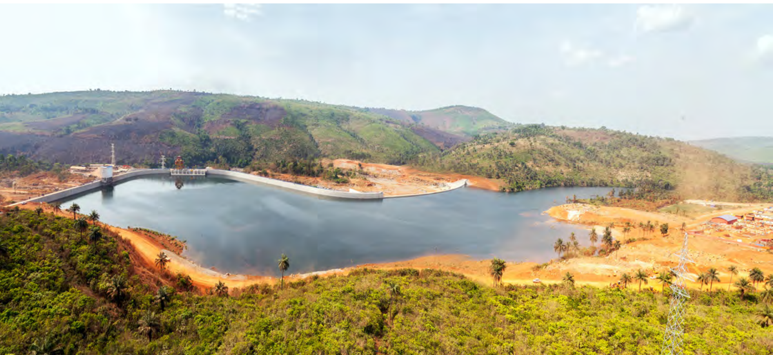
凯乐塔大坝全景
