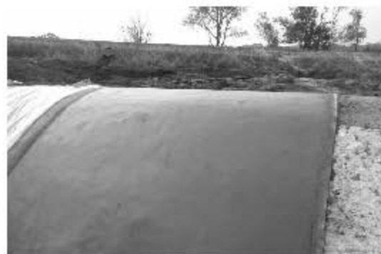
图9 溢流坝混凝土修补施工现场照片
